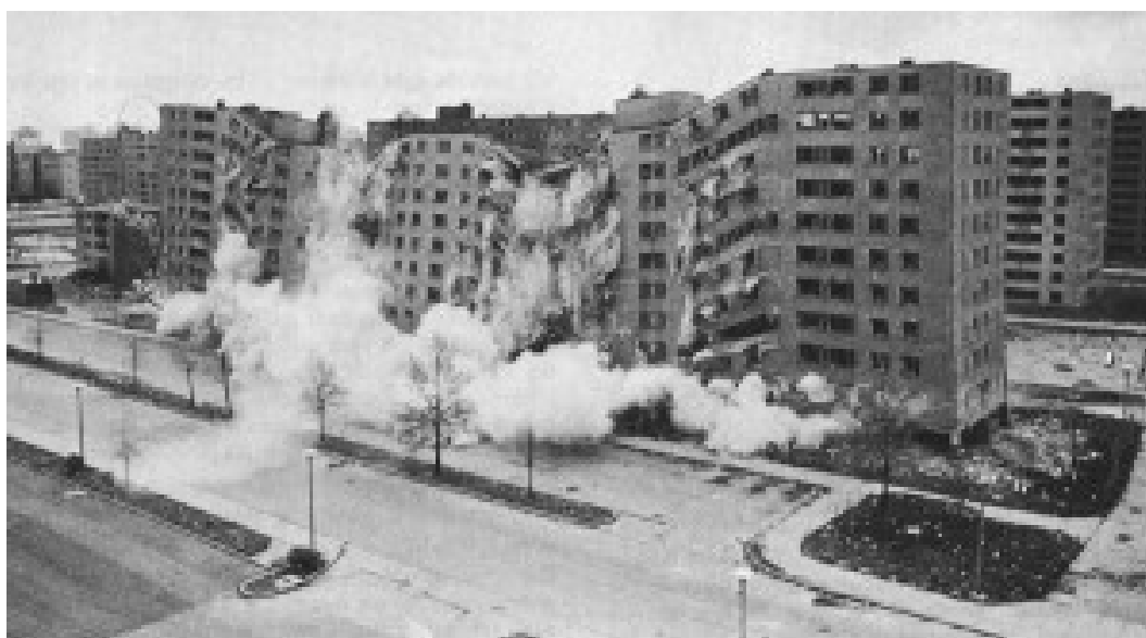
Figura 2: Imagem da demolição do edifício Pruitt -Igoe.
